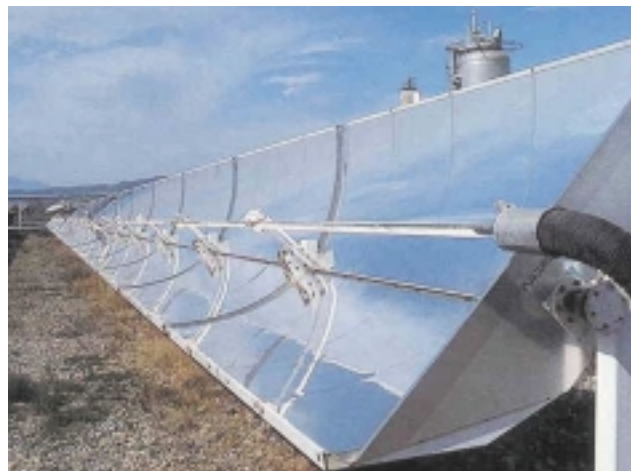
Figura 8. Captador cilíndric-parabòlic amb l'eix orientat en sentit est-oest.
