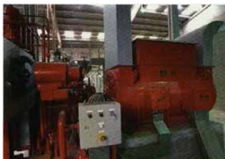
El turbogenerador de vapor té una potència elèctrica de 1.730 kW.
