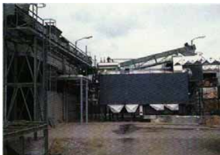
Vista general d'una de les línies de producció de vapor.
