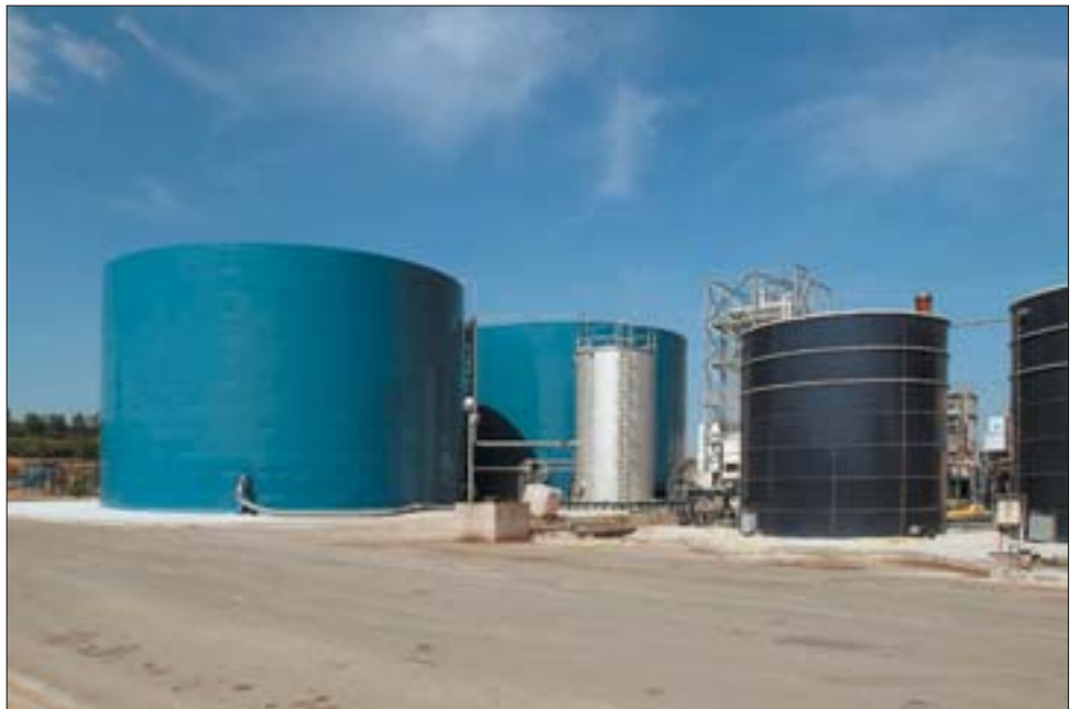
La planta de tractament tèrmic eficient de purins de Juneda té una capacitat de tractament de 110.000 tones anuals.
