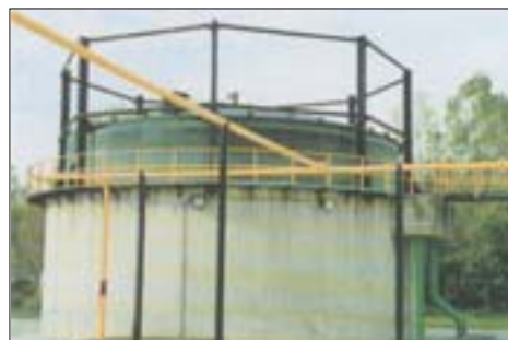
Digestor secundari en una depuradora d'aigües residuals
