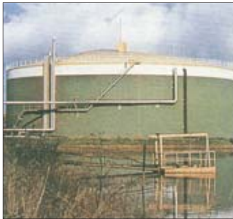
Els digestors de metà o plantes de biogàs són les instal·lacions especialment dissenyades per optimitzar el procés de descomposició anaeròbia de la matèria orgànica.
