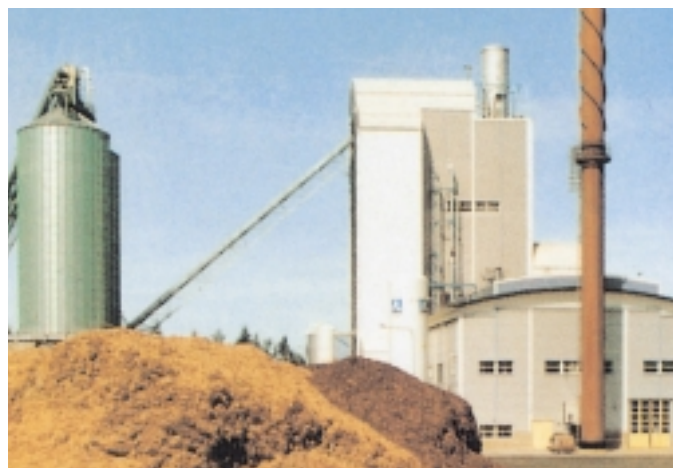
Planta de gasificació a alta pressió.
