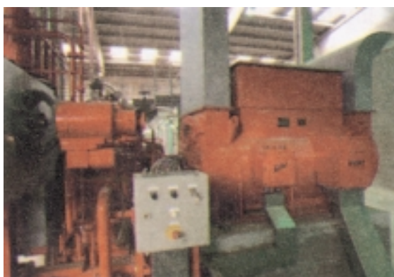
Instal·lació d'una turbina de vapor.
